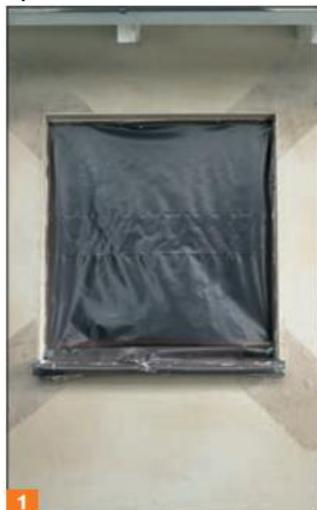
8.1.Полосы стеклосетки на углах На всех 4 углах необходимо произвести усиление угла дополнительной полосой стеклосетки.
