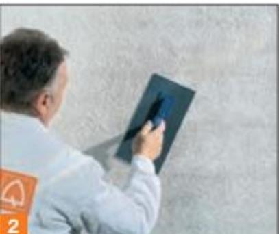
9.2. Структурирование Сразу после нанесения штукатурки можно структурировать ее поверхность. В результате после затирания штукатурки получаются классические рисунки типа «шуба» или «короед». По желанию можно применять различные инструменты и получать самые разнообразные рисунки.
