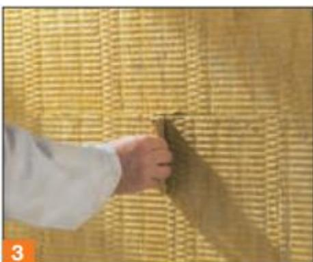
**3.2.7 Заполнение швов** Открытые швы в минераловатных теплоизоляционных плитах заделываются остатками того же изоляционного материала, чтобы избежать образования мостиков холода.
