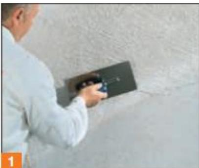
9.1 Нанесение штукатурки Нанесение тонкослойной декоративной штукатурки, например, штукатурки «шуба» SPS или «короед» MRS, производится слоем толщины зернистости штукатурки с гладилкой из нержавеющей стали.
