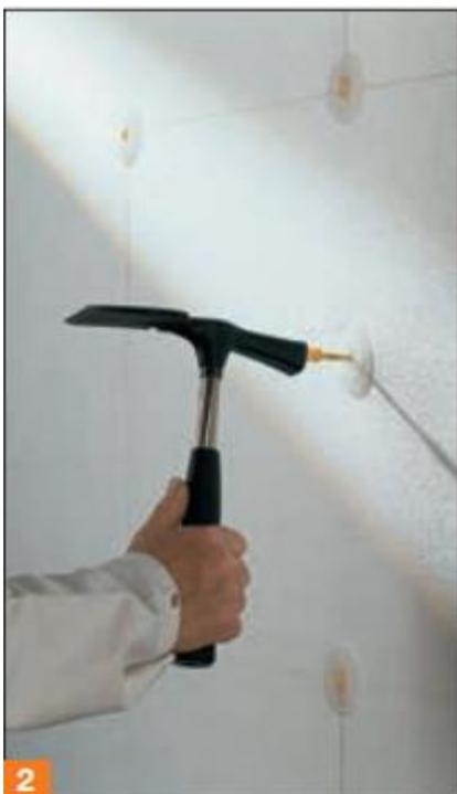
5.2. Забивной дюбель Механическое крепление теплоизоляционных плит из пенополистирола производится под стеклосеткой. Для фиксации утеплителя можно использовать также забивные дюбели. Забивные и винтовые дюбели обеспечивают дополнительную прочность крепления.
