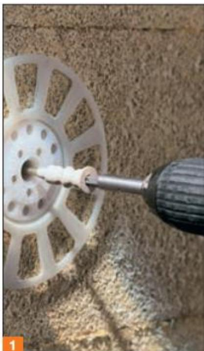
При выборе дюбеля необходимо руководствоваться плотностью материала стены в которую вы крепитесь если плотность до 1000 кг/м<sup>3</sup> то используем винтовой дюбель, если от 1000 кг/м<sup>3</sup> и выше, то можно использовать как винтовой так и забивной!
