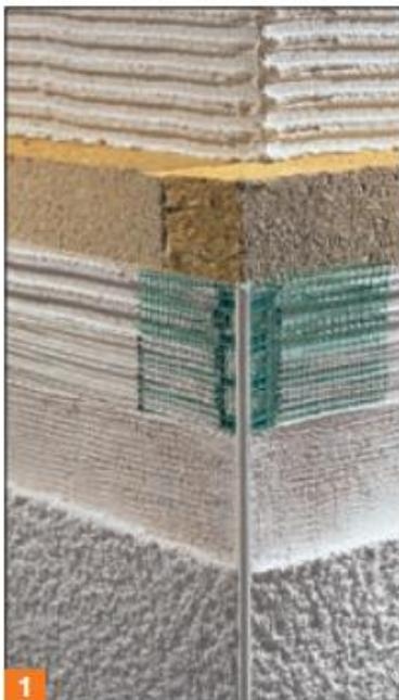
6.1. Заделка Углов Угловой профиль со стеклосеткой для усиления кромок декоративной штукатурки утапливается непосредственно в армирующий слой. Гладкая угловая кромка профиля остается видимой, штукатурный слой разравнивается вдоль нее. Армирующая стеклосетка профиля перекрывает внахлест стеклосетку армирующего слоя по всей поверхности.
