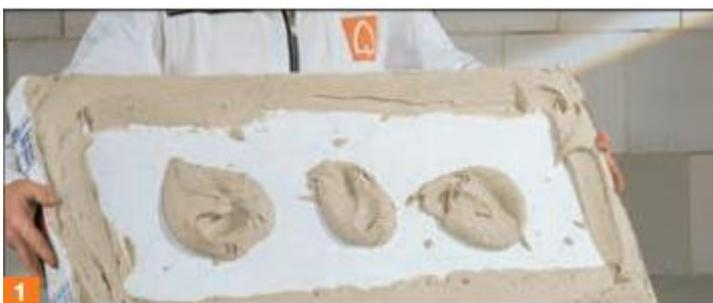
3.1.1 Нанесение клея методом «Валик-кулич» Клеящий и армирующий раствор KAS наносится сплошным валиком с отступом от края по периметру и несколькими куличами в центре плиты. Поверхность приклеивания должна составлять не менее 40 %.
