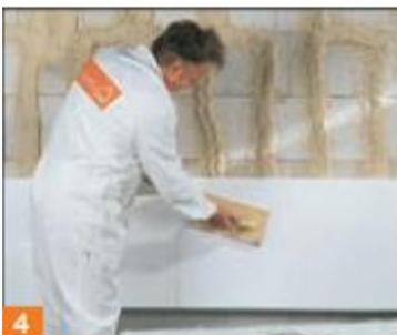
3.1.4. Наклеивание теплоизоляционных плит Теплоизоляционная плита незамедлительно, не позднее чем через 10 минут, прикладывается и слегка вдавливается в свежий клеевой раствор. После этого плиту следует подогнать и прижать длинной теркой для полного приклеивания.
