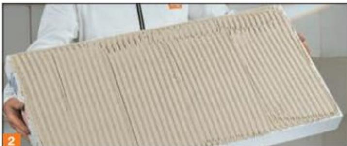
3.1.2. Нанесение клея зубчатым шпателем При приклеивании на ровном основании вместо метода «Валик-кулич» раствор может быть нанесен сплошным слоем по всей изнаночной поверхности плиты. Перед приклеиванием следует разровнять слой клея зубчатым
