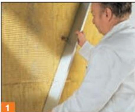
**3.2.5 Проверка плоскостности поверхности** Перед нанесением армирующего слоя поверхность теплоизоляционной плиты необходимо проверить специальной линейкой или теркой на наличие неровностей.
