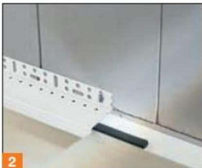
6.4.2. Примыкание к цоколю Если в зоне цоколя также будут положены изоляционные плиты, то уплотнительная лента предотвращает попадание влаги в конструкцию. Лента укладывается между изоляционным материалом и цокольным профилем.
