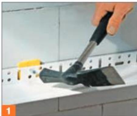
2.1.Монтаж цокольных профилей Цокольные профили крепятся забивными металлическими дюбелями (например, профильный дюбель) из расчета 3 дюбеля на один погонный метр.
