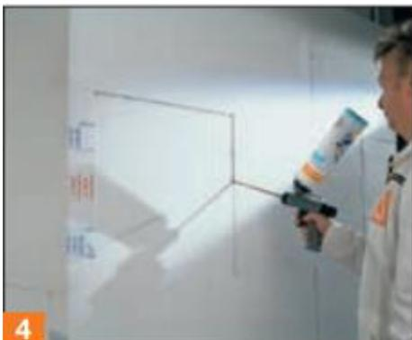
3.2.8. Заполнение швов При применении теплоизоляционных пенополистирольных плит открытые швы можно заполнить монтажной пеной. При этом из противопожарных соображений следует в любом случае применять пену класса горючести В1.
