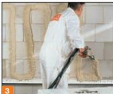
3.1.3. Нанесение клея машинным способом В случае применения EPS-плит клей можно наносить полосами непосредственно на каменную кладку. При этом клей наносится не менее чем на 60% поверхности основания, а расстояние между полосами клея не должно превышать 10 см.
