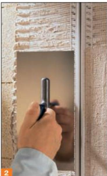
6.2. Деформационные швы При устройстве деформационных швов на наружных поверхностях, например на междомовых стенах, следует соблюдать условия и параметры из проектной документации. Деформационные швы между отдельными частями здания при монтаже системы утепления обязательно следует учесть и оснастить соответствующими деформационными профилями. Эти профили втапливаются в армирующий слой, а стеклосетка на кромках профиля перекрывает внахлест стеклосетку поверхности фасада.
