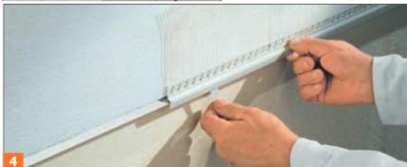
2.4. Установка капельника на цокольном профиле После установки и приклеивания изоляционных плит на цокольный профиль прикрепляется капельник с армирующей сеткой. Таким образом,
