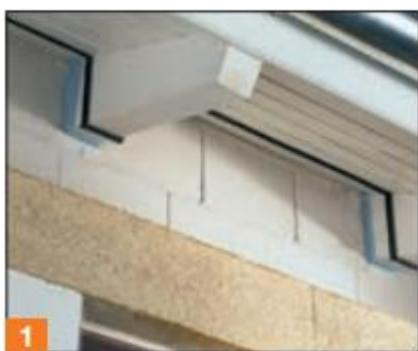
6.4.1.Примыкание к кровле Место примыкания системы к кровле также должно быть герметичным, чтобы избежать попадания влаги и сырости в конструкцию. Здесь также поможет саморасширяющаяся уплотнительная лента, которую можно клеить как на стропила, так и на панели каркаса.
