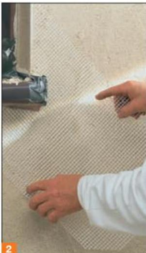
8.2. Косынки из стеклосетки Альтернативно на углах оконных и дверных проёмов для восприятия местных напряжений производится дополнительное диагональное армирование углов косынками стеклосетки. Косынки укладывают на углах поверх основного слоя армирующей сетки.
