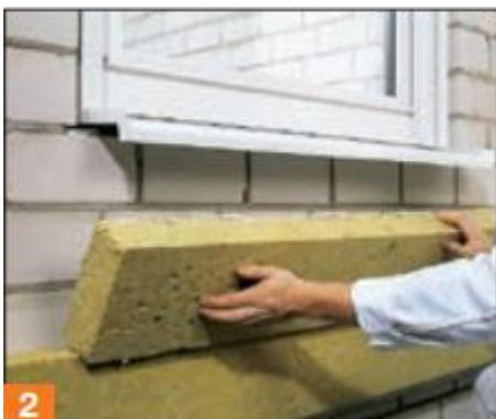
3.2.2 Приклеивание плит типа «Ламелла» В случае применения минераловатных плит Ламелла клеевой раствор следует наносить исключительно сплошным слоем по всей поверхности плиты, как это описано в п. 1.
