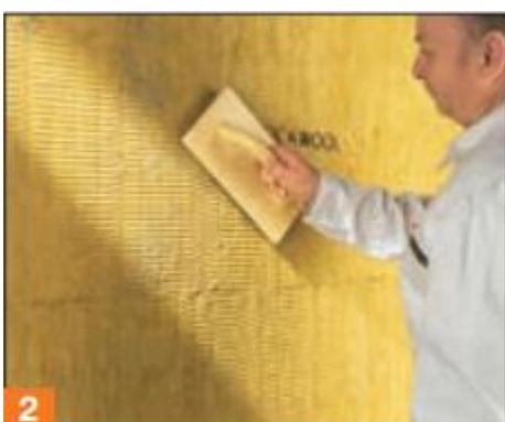
**3.2.6 Обстукивание теплоизоляционных плит** В целях получения плоской ровной поверхности теплоизоляционные плиты необходимо утрамбовать гладилкой или подобным инструментом. В случае наличия значительных неровностей их нужно зашлифовать.
